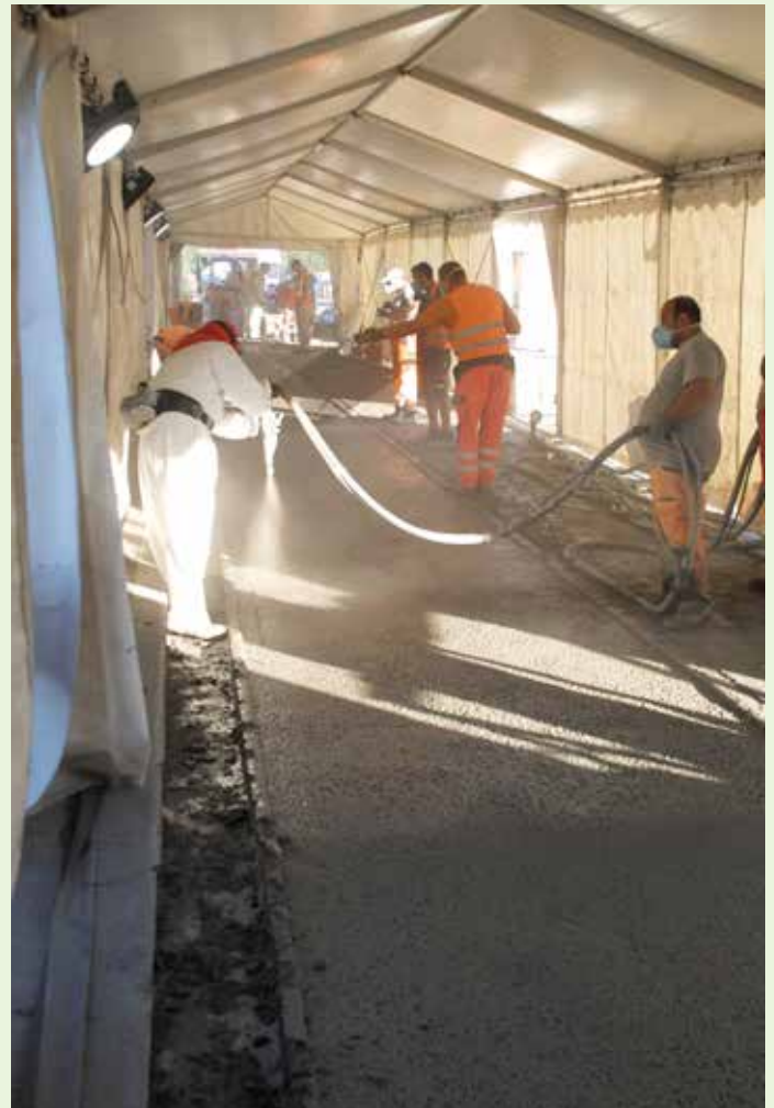
Verstärkungsarbeiten an der Brückenseite Foto: Oliver Steinbock
