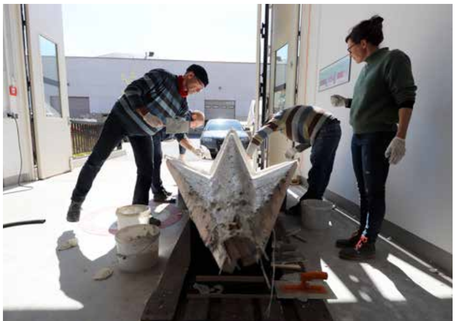
Der „Flyer“ wird ausgeschalt - Alfred-Hütter-Labor des Instituts für Baustoffe der TU Dresden
