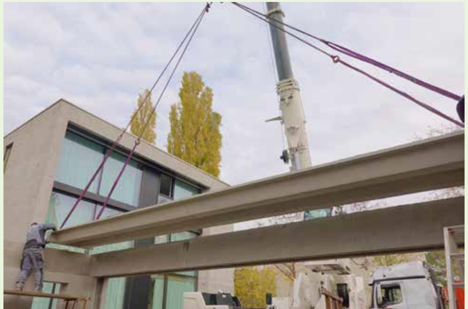
Montage der vorgespannten Trapezplatten für eine Garage in Berlin
