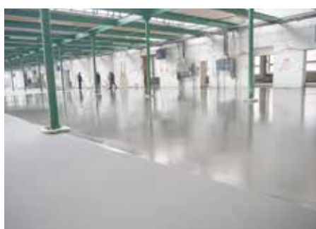
Aufbringen der hoch abriebfesten Deckschicht
