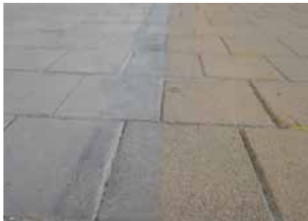
Abgefräster Boden
