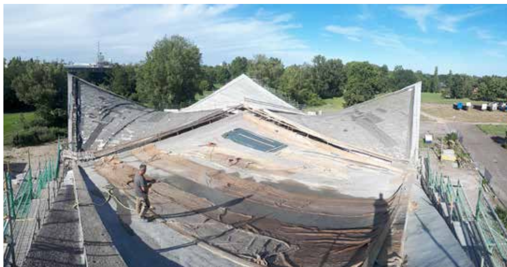
Carbonbetonverstärkung der Hyparschale in Magdeburg
