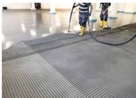
Auf Untergründe abgestimmte Carbonbewehrungen, flexibel und starr, in ein bis drei Lagen
