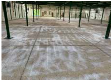
Kugelgestrahlter Boden
