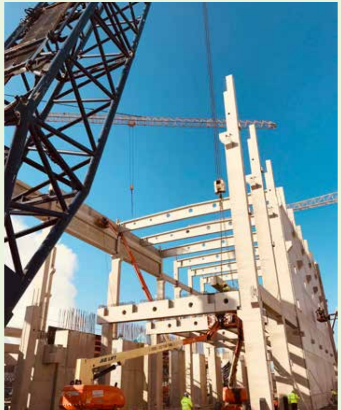
Fertigteilbau mit Vorspannung
