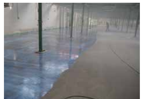
Aufbringen der Ausgleichsmasse
