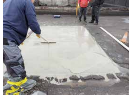
Abb. 2: Feldversuch zur Optimierung von carbonbewehrten hoch verschleißfesten WHG-Dichtflächen
