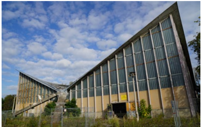
Foto aus 2017 zum aktuellen Zustand
