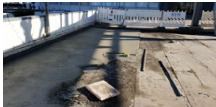
Der Leichtbeton wird flächig zur Verbesserung der Gefällesituation eingebaut.
