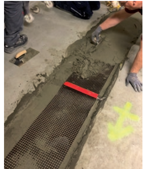
Einbau KKS-Carbonbeton im Laminierverfahren – roter Bereich: Primäranodeneinspeisung
