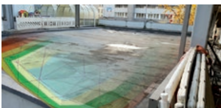
Brückenfläche nach Abtrag der Betonfertigteilplatten mit graphischer Darstellung der Höhenmessungen
