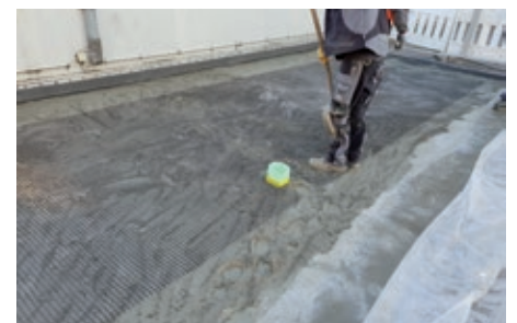
Einlaminiert des Carbongeleges in Konstruktionsmörtel auf der ausgehärteten Leichtbetonschicht
