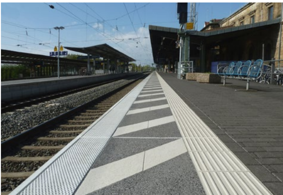
Bahnsteig in Erlangen nach der Sanierung: Durch den Einsatz von modula flex als Ergänzungsplatte konnte der Abstand der konventionellen Bahnsteigkante zur neuen Gleisgradiente angepasst werden.
