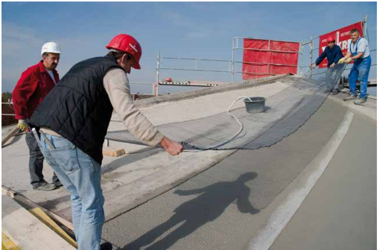
Verstärkung eines Hyparschalendachs in Schweinfurt
