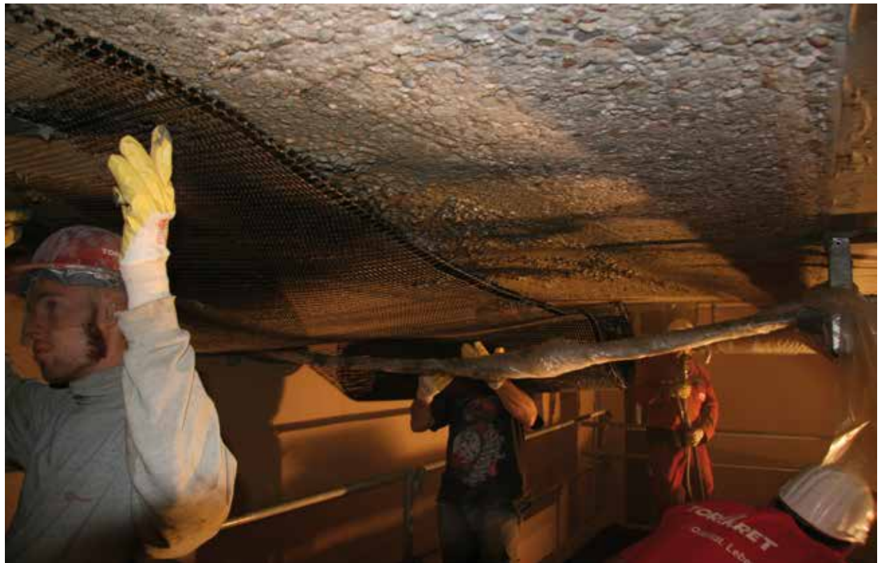
Textilbetonverstärkung Canyon Bicycles GmbH in Koblenz
