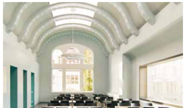
Tonnengewölbe Finanzamt Zwickau nach der Verstärkung
