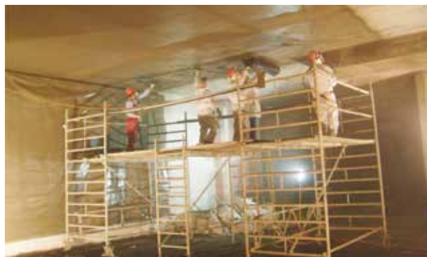
Verstärkung einer Kaufhausdecke in Prag
