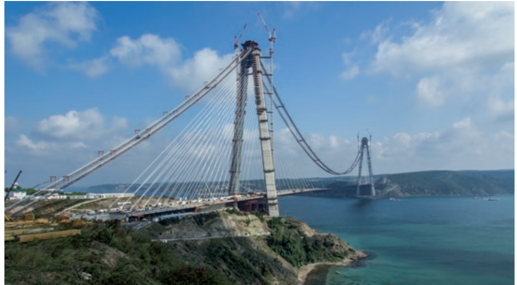
Die Brückenpylone sind extrem hohen Windlasten von 300 kg/m 2 ausgesetzt.
