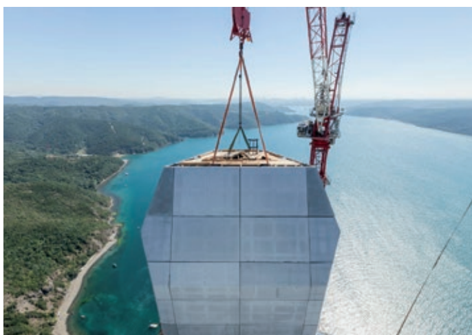
Das maximale Plattengewicht von 110 kg/m 2 war nur mit einer GRID-Bewehrung von solidian zu erreichen.
