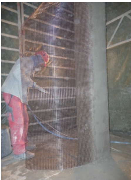
Feinbetonauftrag im Spritzbetonverfahren Foto: Erich Erhard
