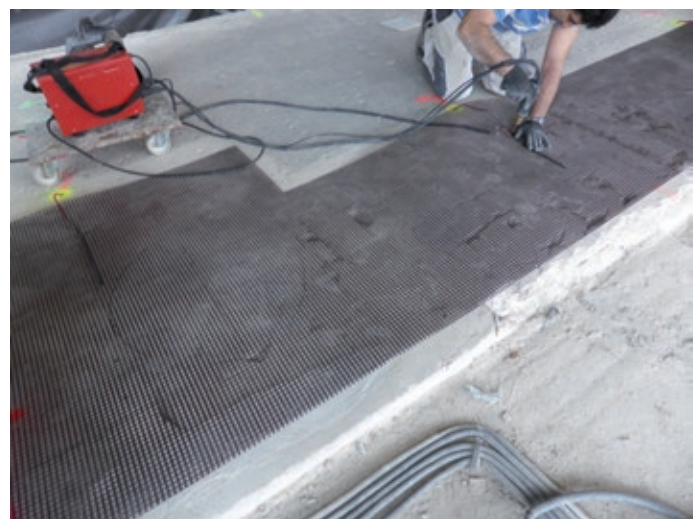
Elektrischer Anschluss des Carbongeleges im Bereich Beckenumgang eines Schwimmbades. Foto: Koch
