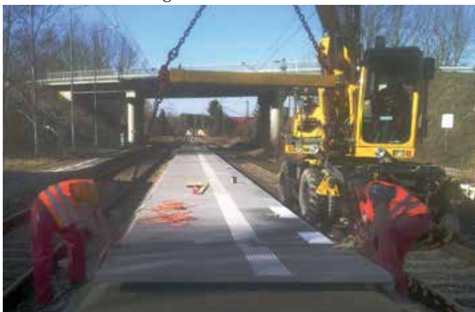
Montage der Platten.
